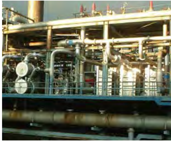
석유화학 플랜트의 냉각수의 냉각 (반 용접 가스켓 타입 PHE)
